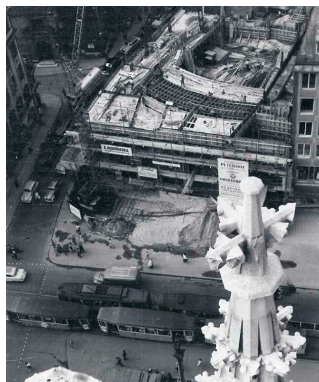
Der neue Peterhof entsteht.
