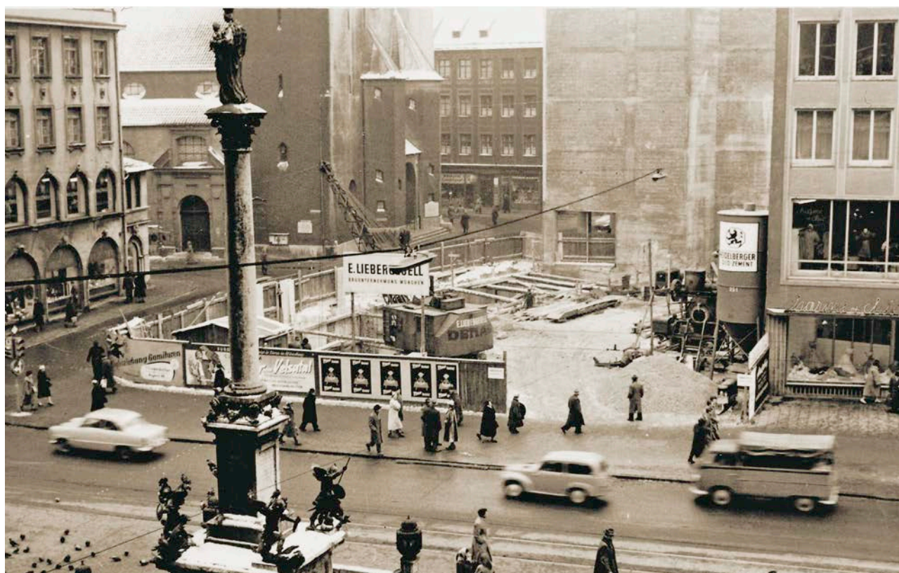
Tabula rasa: Großbaustelle mitten in der Stadt.
