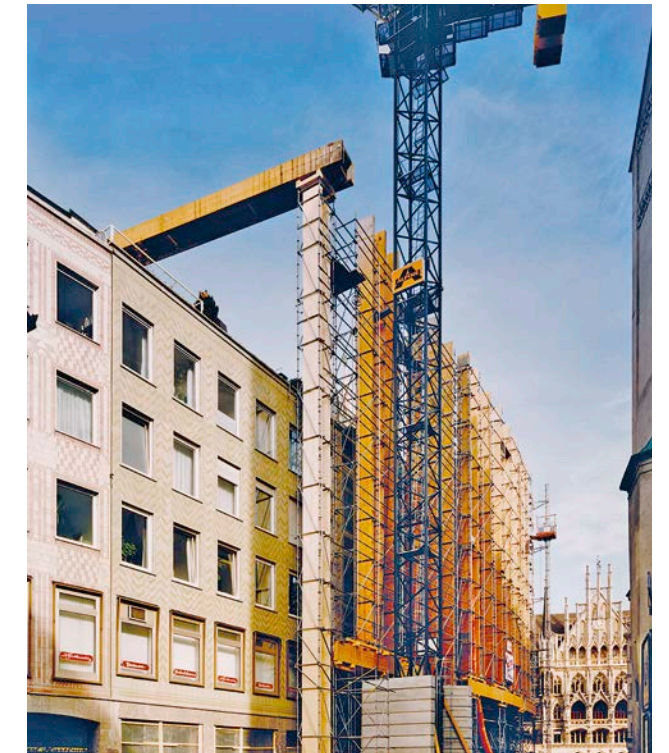
Fassadenbauarbeiten zum Rindermarkt hin.
