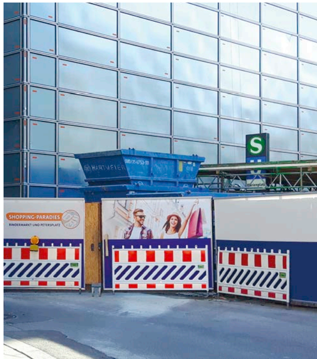
Verantwortungsvolles Bauen: dank Schalldämmkassetten und fußgängerfreundlicher Baustelleneinrichtung.
