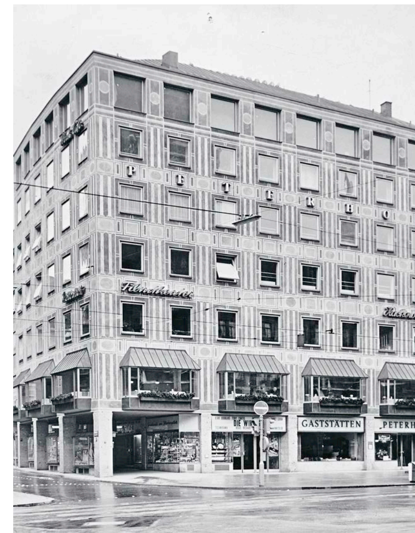
Nüchterer Neutralbau: Nur die Fassadenbemalung erinnert an die frühere Pracht.
